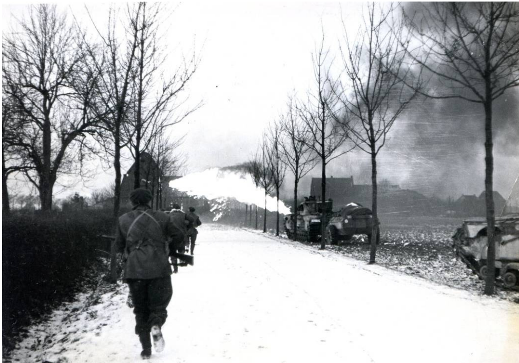
Vlammenwerper in actie op St. Joosterweg, links de contouren van het transformatorhuisje.
